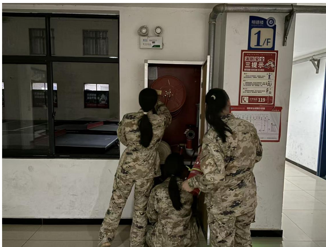
图 2-7 安全隐患排查
